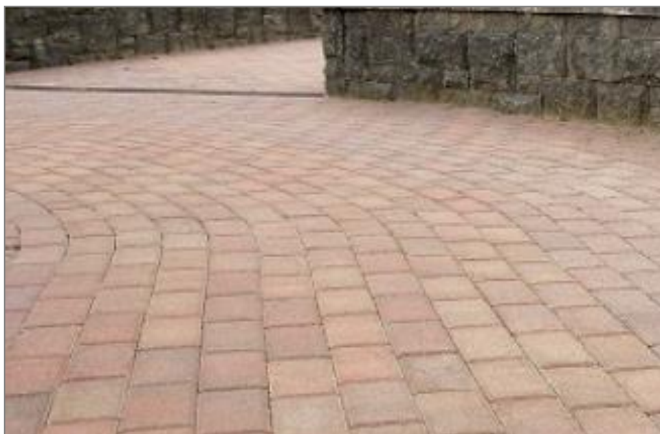
Figura 5:1 – Esempio di pavimentazione permeabile mediante betonelle autobloccanti
