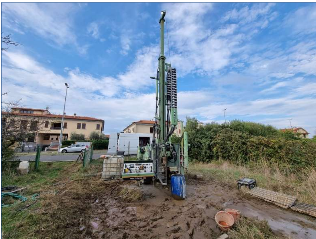
Figura 1: Sondaggio S1 - Postazione
