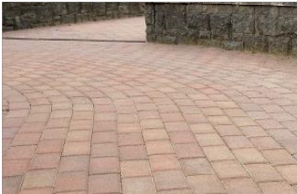
Figura 7:1 – Esempio di pavimentazione permeabile mediante betonelle
