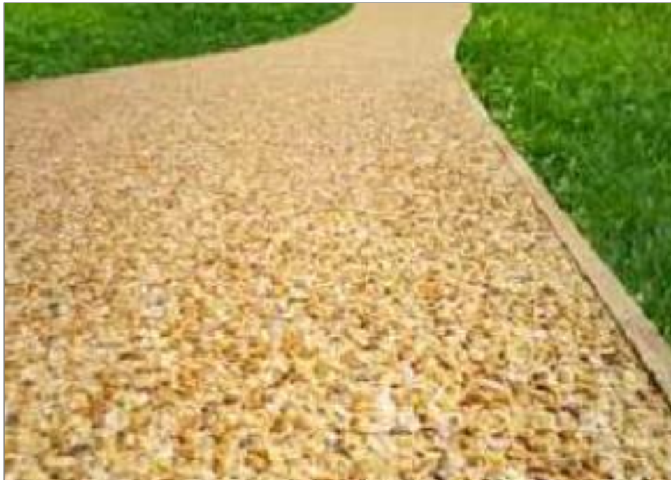
Figura 7:2 – Asfalto drenante colorato previsto per il percorso pedonale (fonte: Tav. 14a "Piazza ambientale funzionale Parco circolare – strutture leggere di pertinenza al parco")
